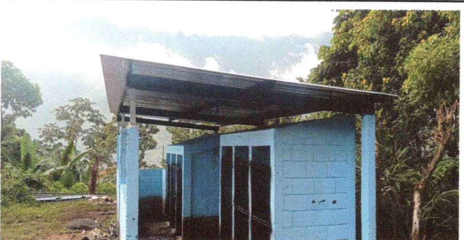
Foto 5: Reparación y pintura de puertas y sustitución laminas y mantenimiento de estructura de techo.
