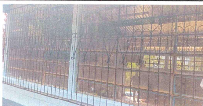
Foto 2: Sustitución de vidrios quebrados por vidrios nuevos en las ventanas de las aulas.
