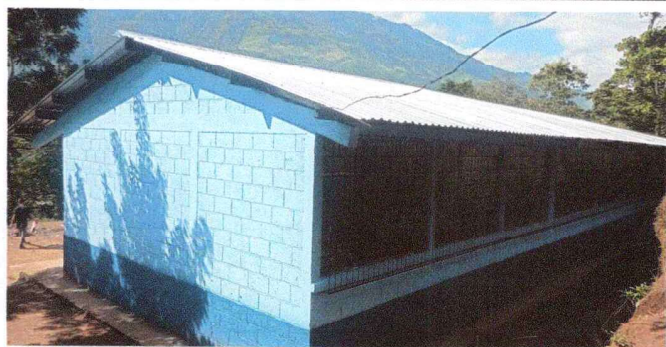
Foto 1: Instalación de laminas troqueladas cablibre 26 y mantenimiento de estructura de techo en el módulo principal.
